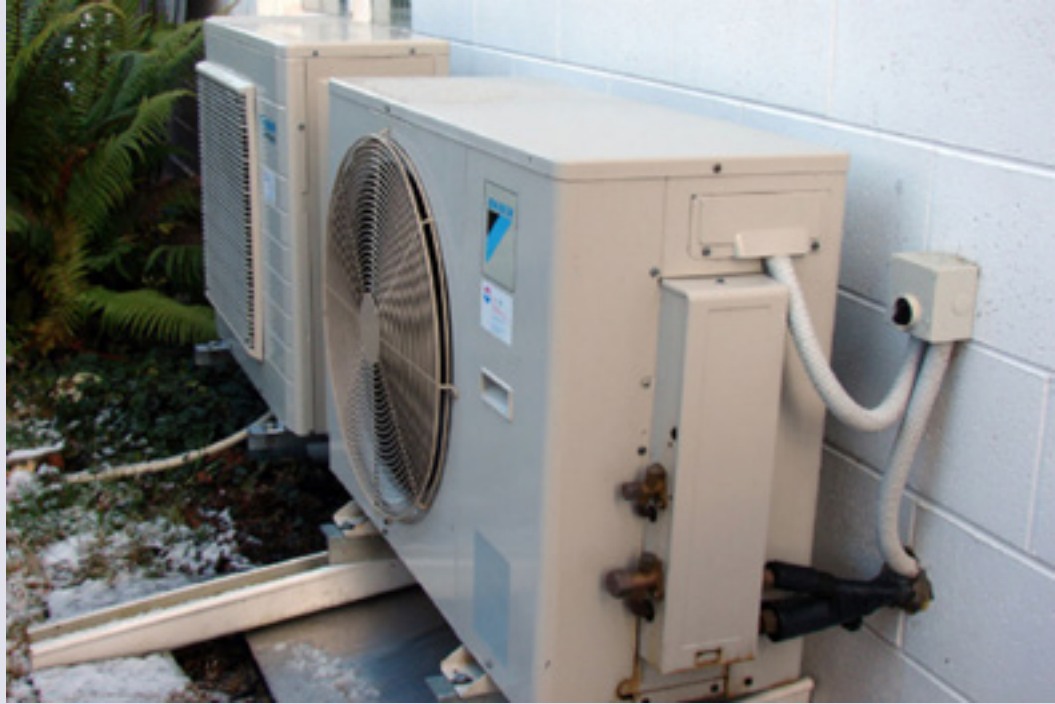
图9：典型空气源热泵
